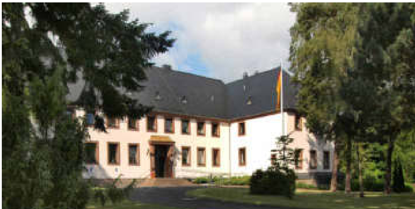
Der Eingangsbereich des Kasinos am Barbaring 75
