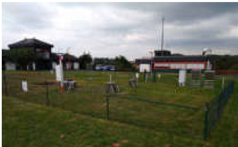
Dienstgebäude und meteorologisches Messfeld
